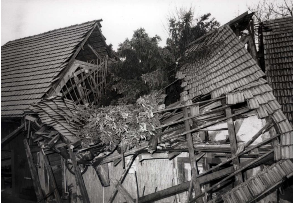
Abb. 1.2: Folge eines auf ein Nebengebäude gestürzten Baumes: Der Dachstuhl ist völlig zerstört
