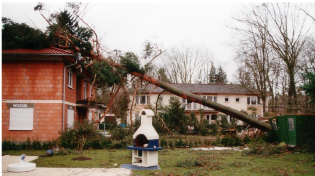
Abb. 1.1: Ein infolge des Orkans „Lothar“ auf ein Wohnhaus gestürzter Baum; teilweise herausgerissener Wurzelstock, Schäden am Dachstuhl
